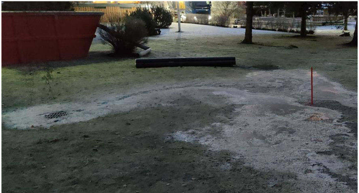
Kuva 2 Työstä syntyvää lietettä ohjattu pihan kuivatusjärjestelmään
