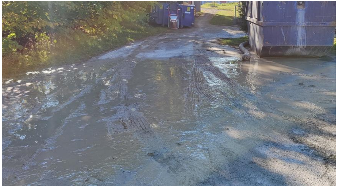
Kuva 1 Työn aikaisen lietteen hallinta epäonnistunut
